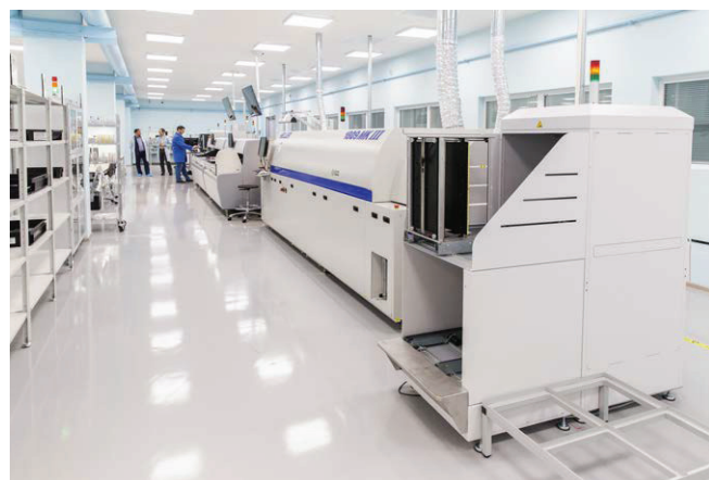
Производственные помещения, оборудованные компанией «Диполь» на предприятиях заказчиков
