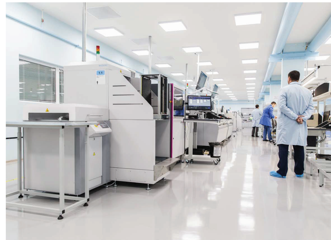
Производственные помещения, оборудованные компанией «Диполь» на предприятиях заказчиков
